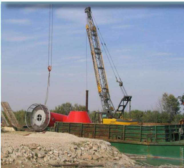
Banchina Fluviale sul Fiume Tagliamento
